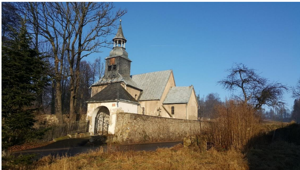
Kościół św. Marcina w Bukowcu
