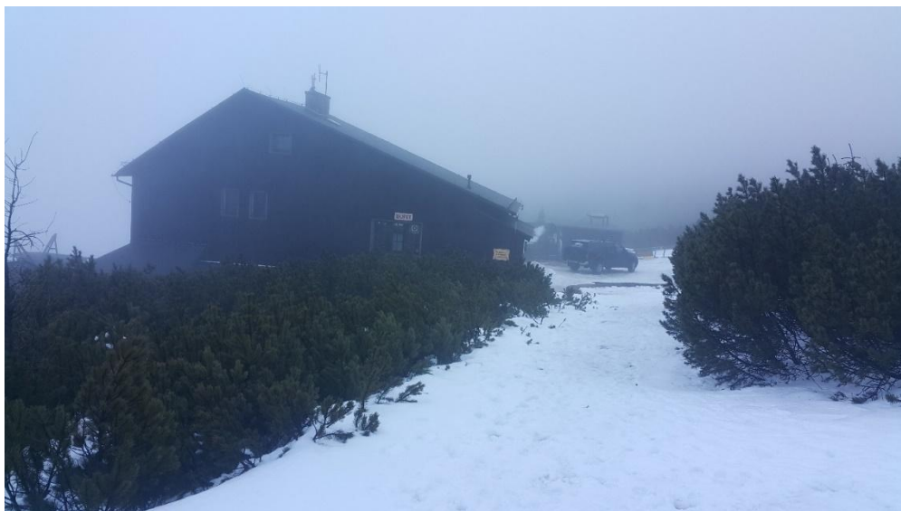
Górna stacja wyciągu na Kopę
