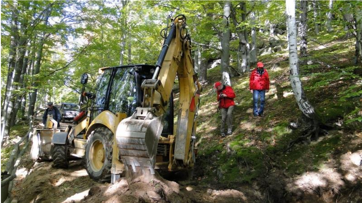
Prace budowlane przy nowej drodze
