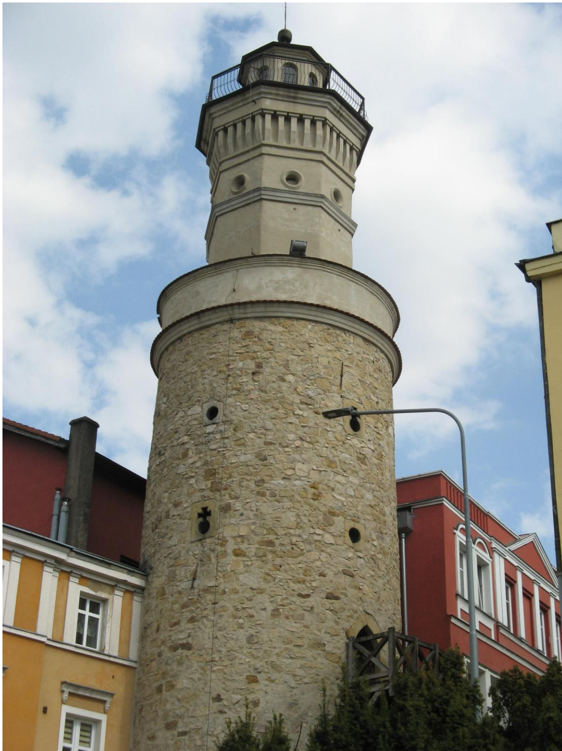
Jelenia Góra – fragment murów obronnych – wieża bramy zamkowej.
