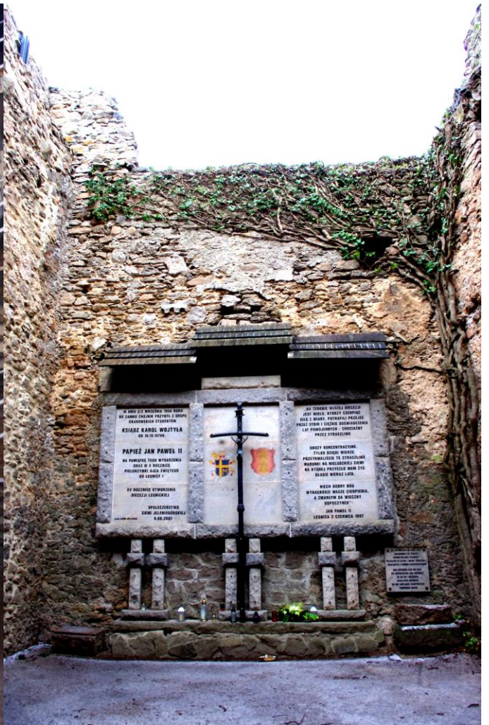
Fot. 4. Widok na mur północny – po III etapie
