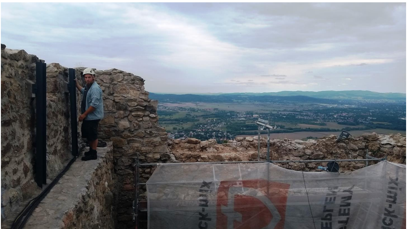
Rys. 5. Widok na zwieńczenie muru północnego (na wprost) – przygotowanie korony muru do umieszczenia wieńca żelbetowego
