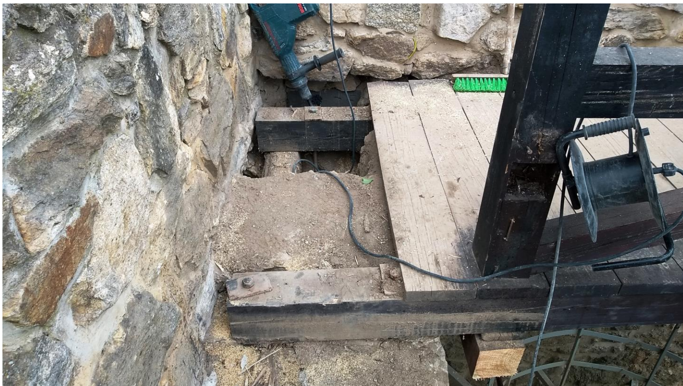
Fot. 13. Demontaż starego pomostu
