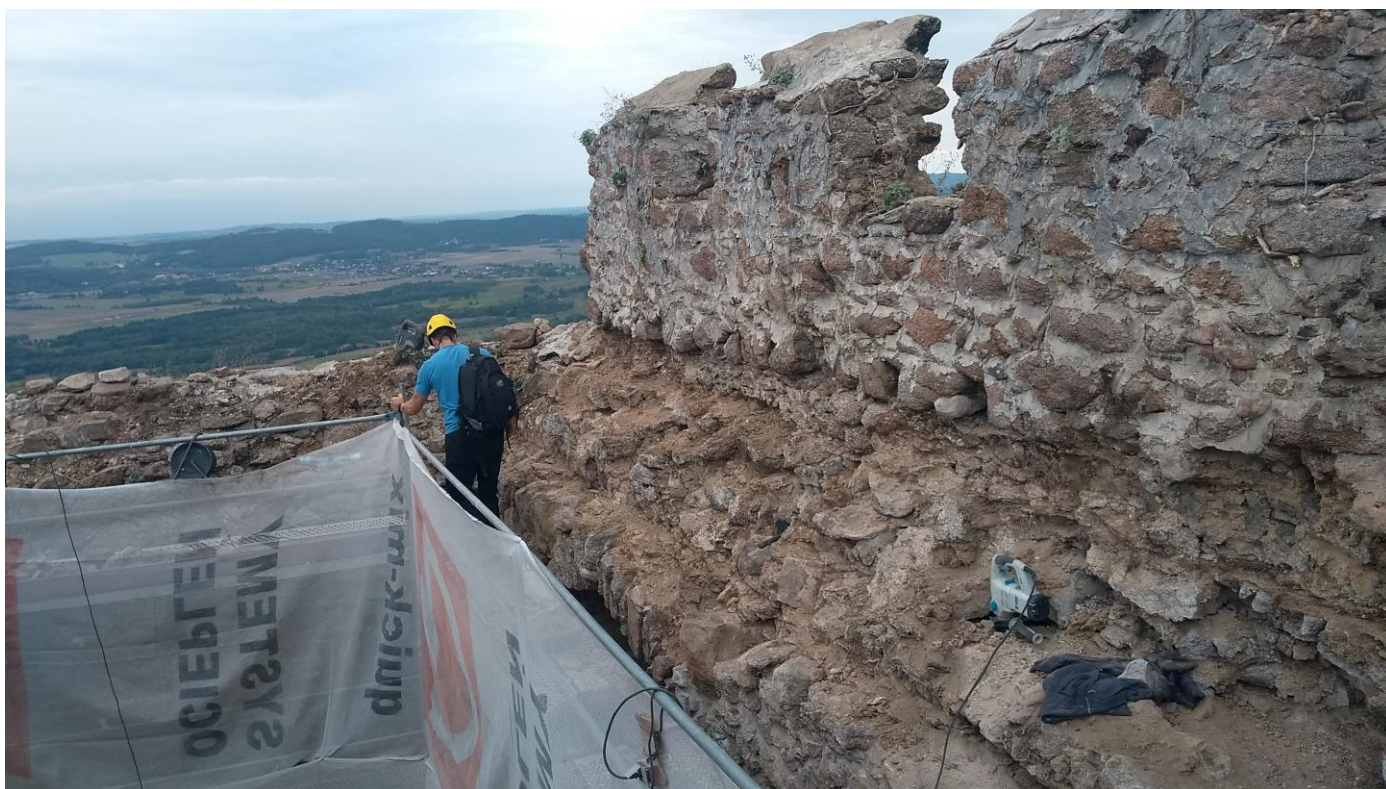
Rys. 6. Widok na narożnik północno-wschodni – przygotowanie muru do ułożenia wieńca żelbetowego oraz stalowych wzmocnień pionowych (EW2). Po prawej widoczna destrukcja muru, jako skutek rozrastania i penetracji muru przez korzenie bluszczu
