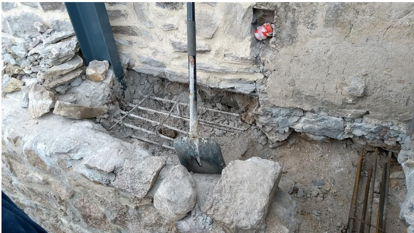
Fot. 11. Miejsce do połączenia wieńców w narożniku muru wschodniego i muru z pomostem
