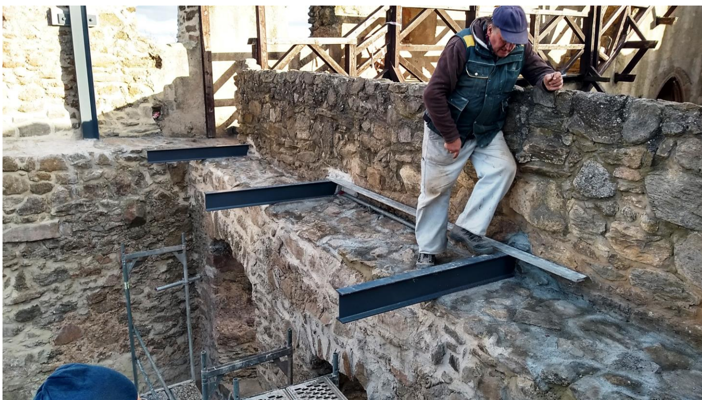
Fot. 14. Mocowanie dwuteowników stalowych jako konstrukcji nośnej pomostu w murze z przykrytym wieńcem żelbetowym
