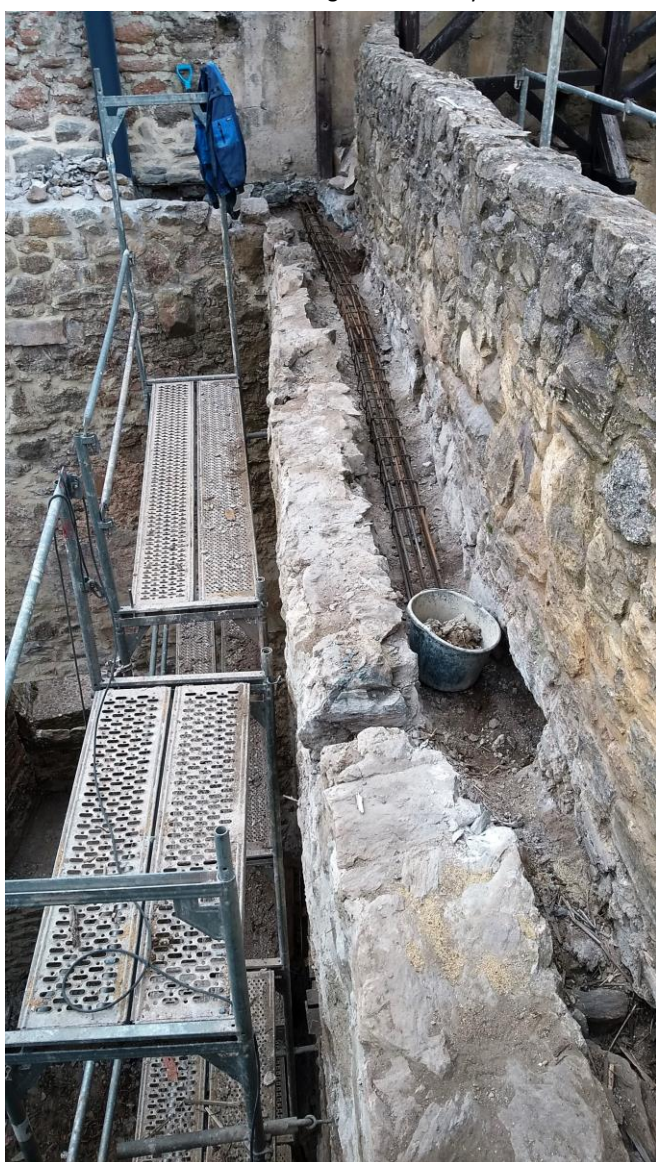
Fot. 9. Wieniec żelbetowy pod pomostem
