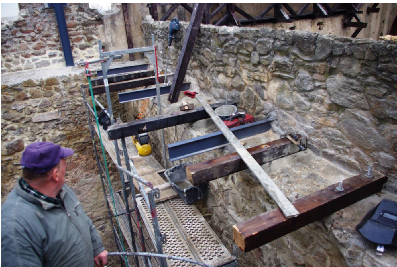
Fot. 18. Montaż poprzeczek drewnianych pomostu
