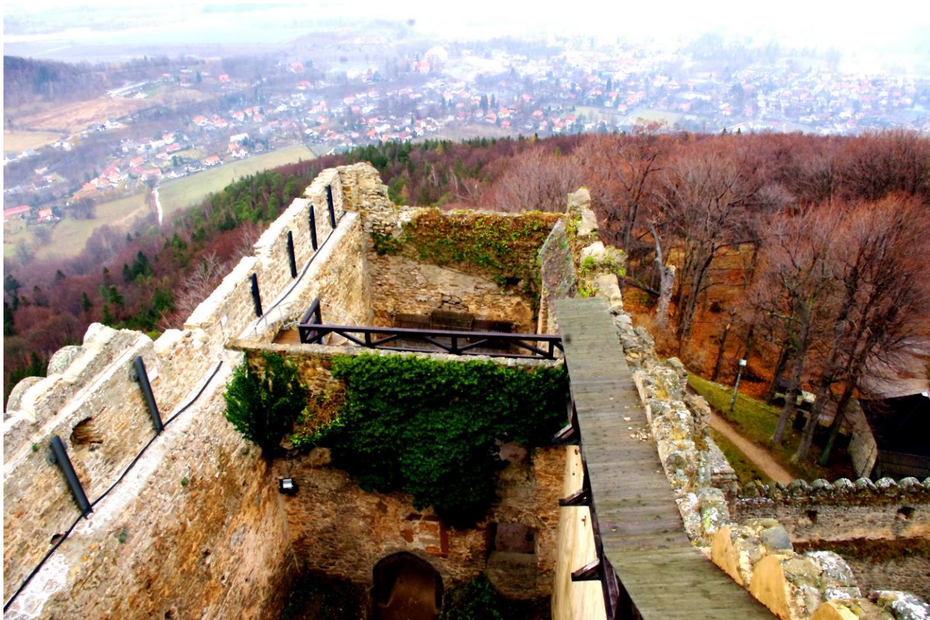
Fot. 1. Widok na pallacium – po III etapie
