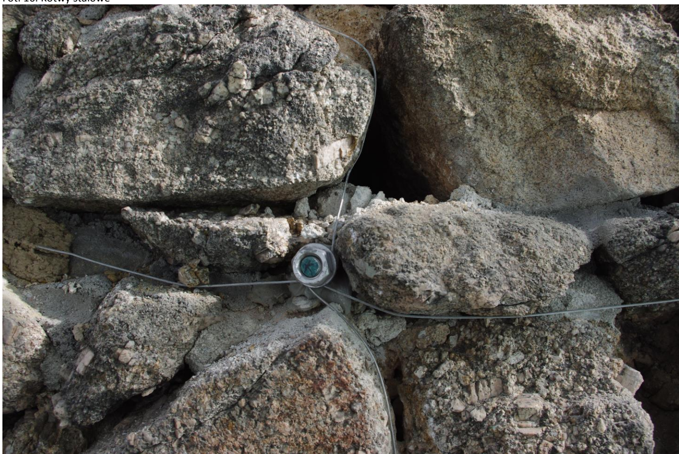
Fot.17. Przykład kotwy i linek ze stali nierdzewnej
