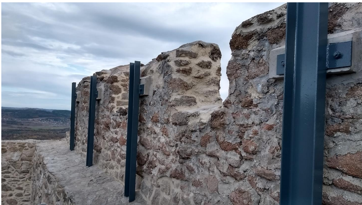
Fot. 12. Wzmocnienie wspornikami stalowymi EW2 i przykryty wieńiec żelbetowy w murze wschodnim
