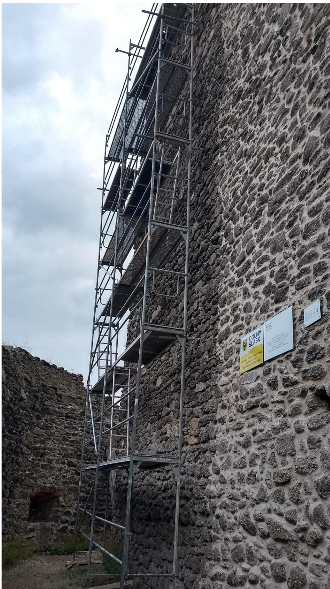
Fot. 15. Wiercenie otworów pod kotwy ze stali nierdzewnej po stronie zewnętrznej muru zachodniego
